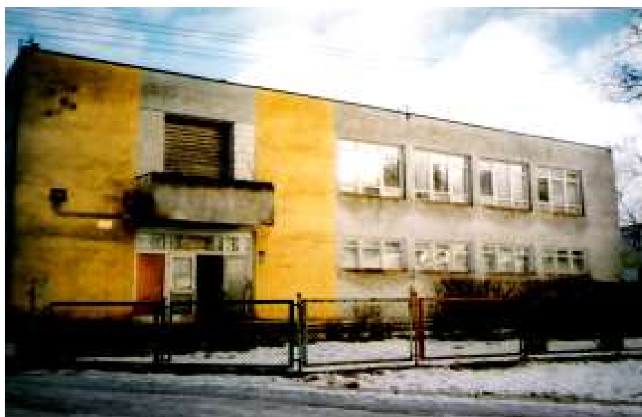
WIDOK BUDYNKU SOCJALNEGO OD STRONY DROGI
